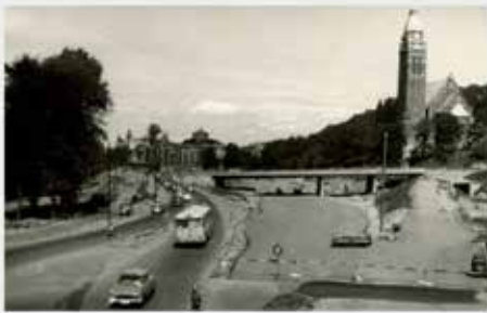
Dag Hammarskjöldsleden byggs. Foto: Hjalmar Wijk, 1961.
